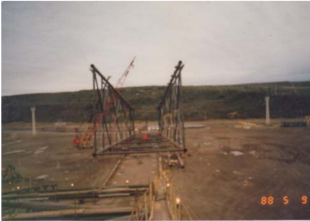
10.- Construcción Plataformas Costa Afuera, Tenenge Chile ESI, Enap Magallanes, Bahía Laredo, Punta Arenas. Vista de frontal de jacket e izamiento de lateral, con 4 grúas, vías de deslizamiento, torres de iluminación en patio de montaje.
