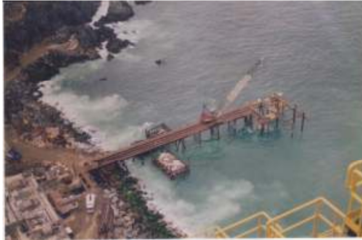
9.- Obras Emisario Esval, Valparaíso, muelle y obra marítima como jacket con dolos, túnel, funicular en ladera acantilado, tramos emisario en hormigón armado, cámara carga, etc.
