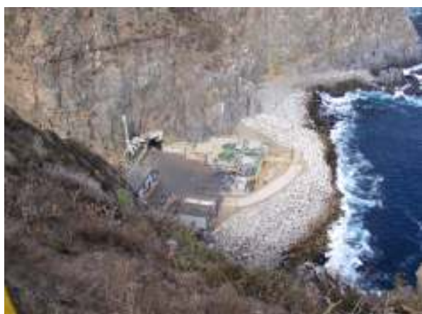
3.- Instalaciones en Loma Larga, boca túnel, Planta desarenadora, cinturón costero dolos y corazas de protección costera. Valparaíso.
