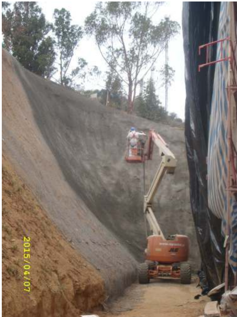
11.- Mirador Peñablanca, vista interior y faena de shotcrete en protección de talud.
