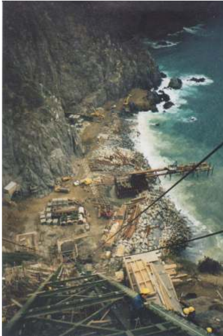
9.- Obras Emisario Esval, Valparaíso, muelle y obra marítima como jacket con dolos, túnel, funicular en ladera acantilado, tramos emisario en hormigón armado, cámara carga, etc.
