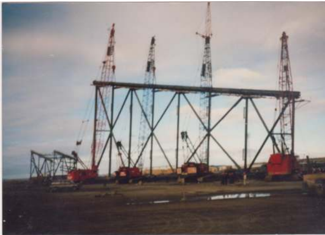
10.- Construcción Plataformas Costa Afuera, Tenenge Chile ESI, Enap Magallanes, Bahía Laredo, Punta Arenas. Vista de frontal de jacket e izamiento de lateral, con 4 grúas, vías de deslizamiento, torres de iluminación en patio de montaje.
